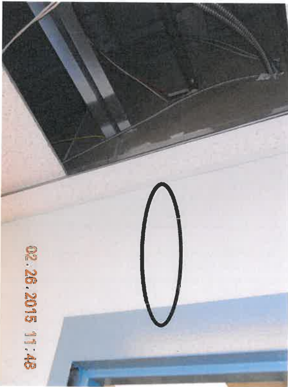
Crack above door
